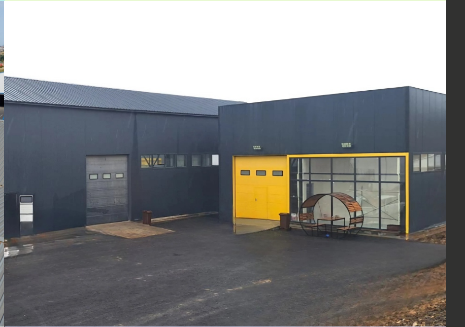
Laçın Kimyəvi maddələr istehsal fabriki Sendviç panel
