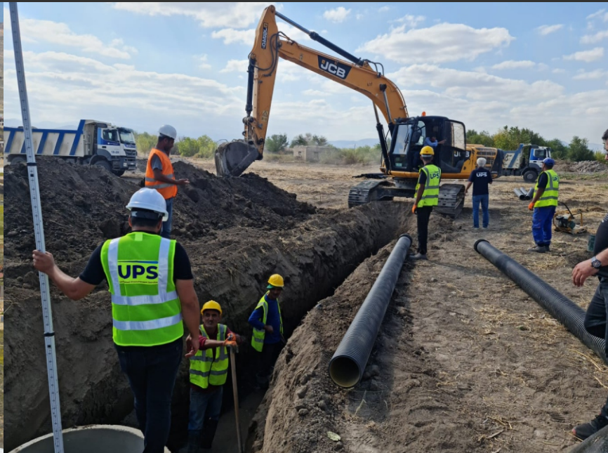
Zəngilan Boru çəkilişi
