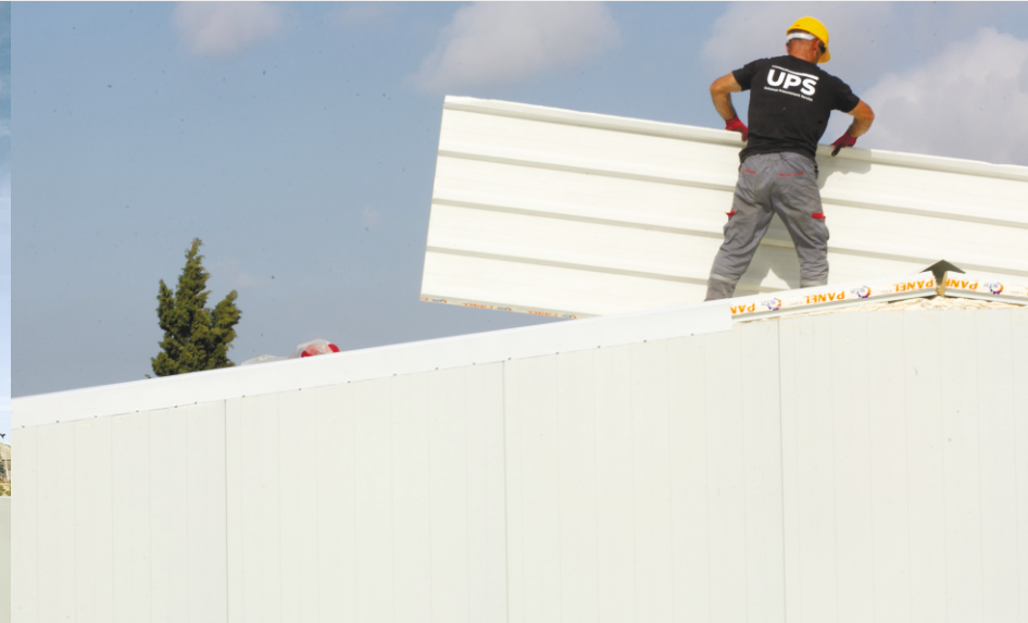
Sendviç panellərin montajı
