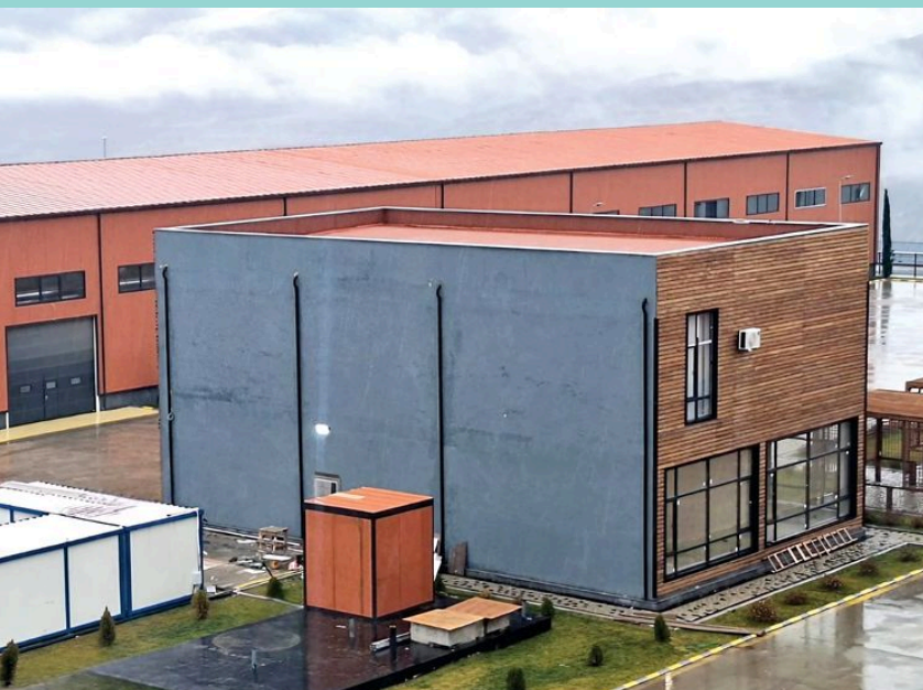
Мебельная фабрика в Лачине Сэндвич-панель
