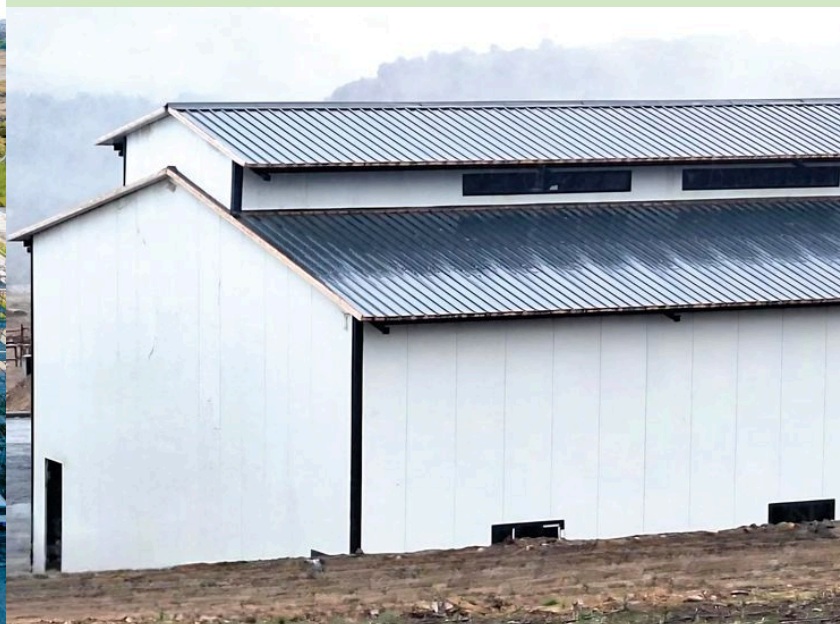
Лачин: завод бетона и черепицы Сэндвич-панель
