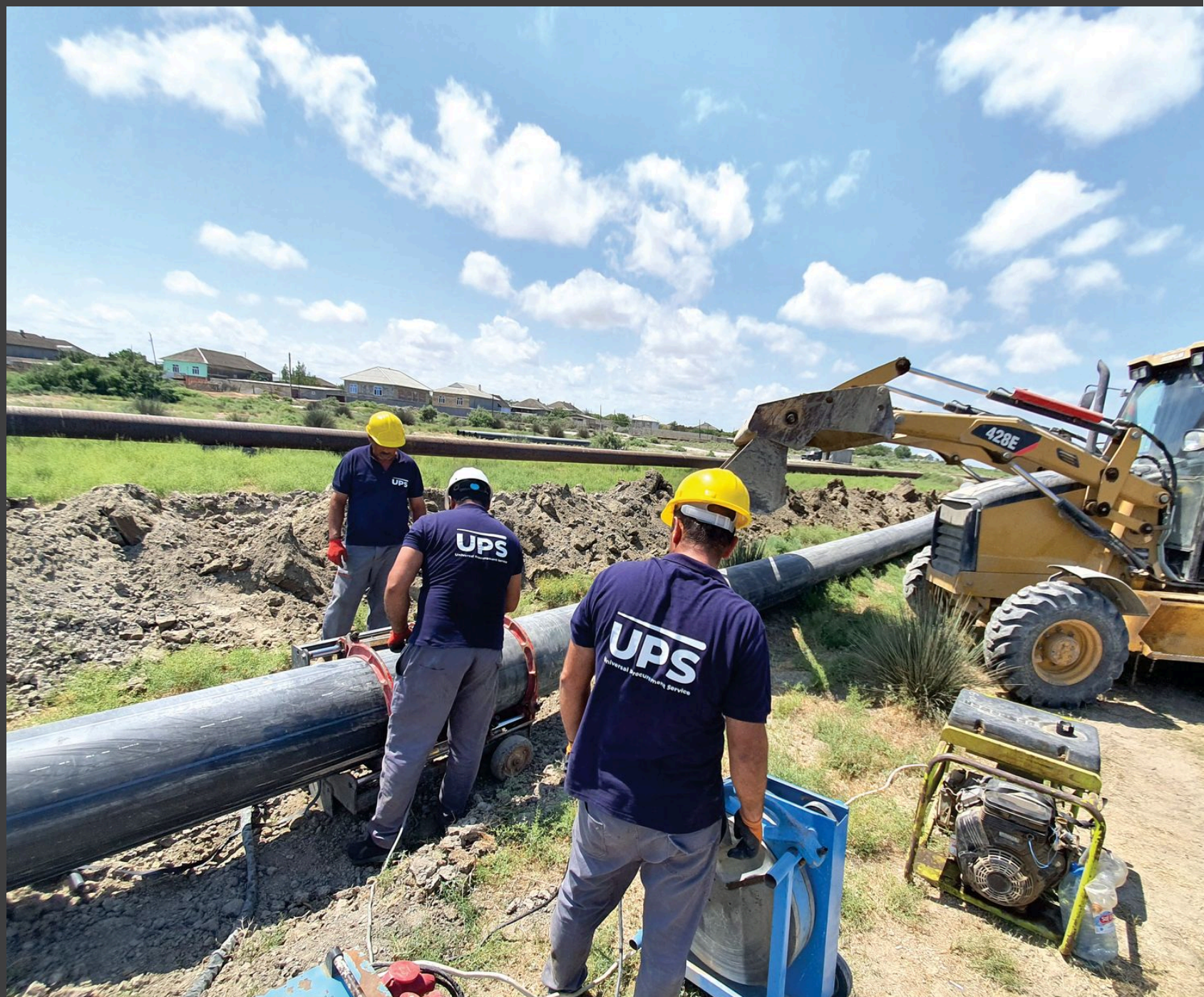
Нефтчала Прокладка труб
