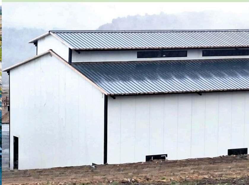
Laçın Beton, Kərəmit istehsal fabriki Sendviç panel
