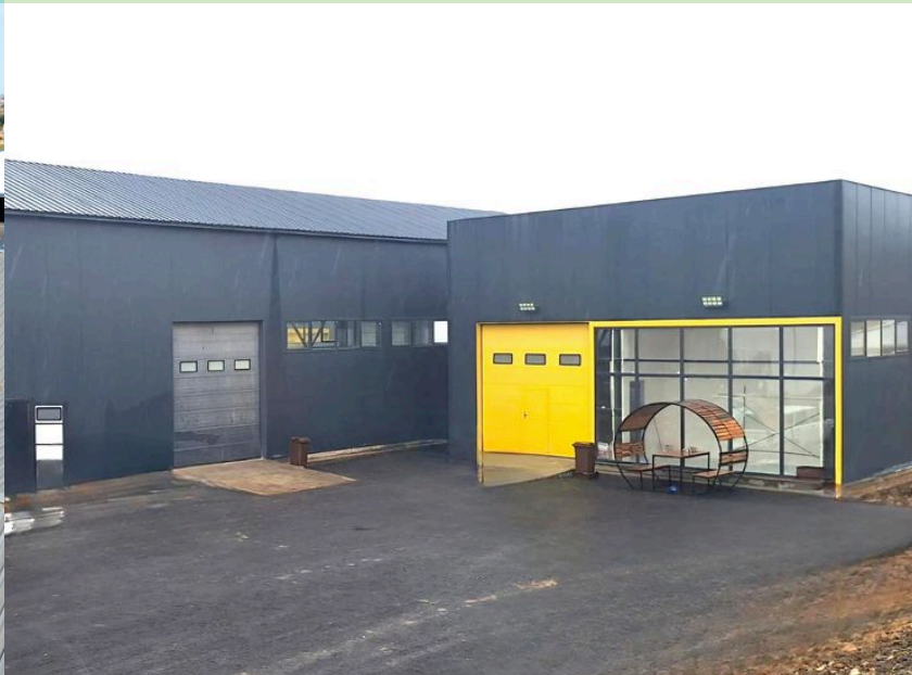
Laçın Kimyəvi maddələr istehsal fabriki Sendviç panel
